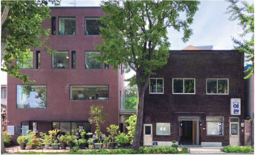
사진 1. 근대시기 문인들의 사랑방이었던 통의동 보안여관. 사진: 월간미술.
